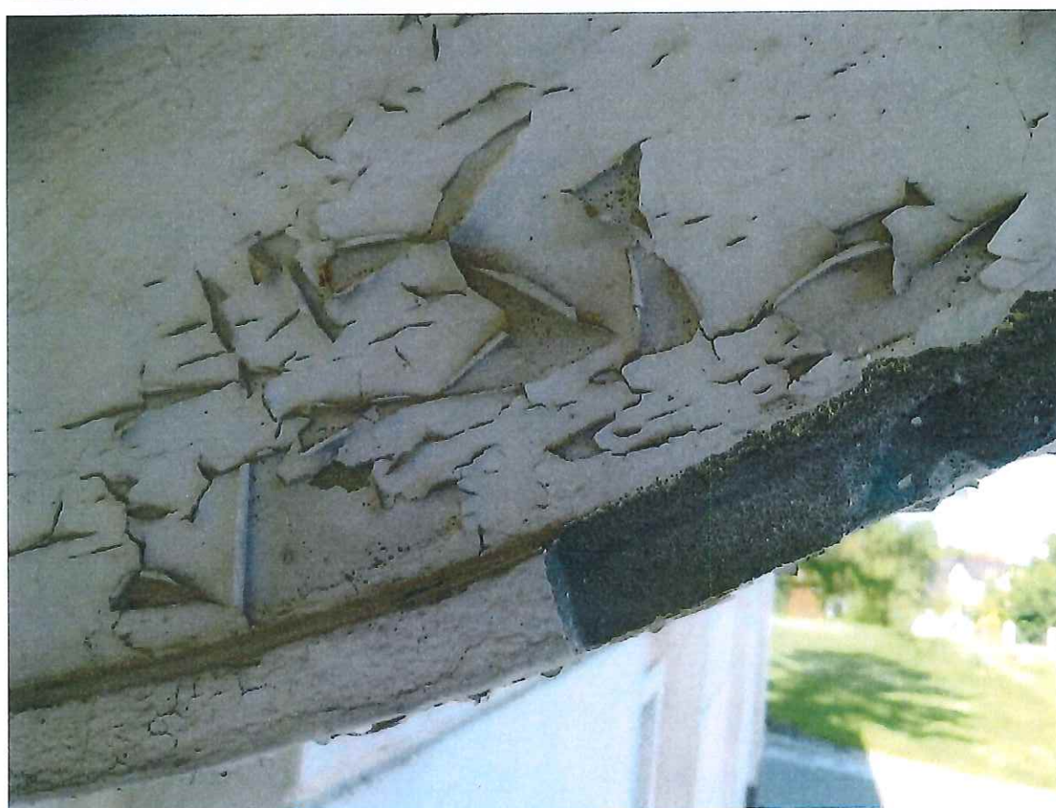
Balkon nad wejściem na elewacji północnej – widoczne wtórne warstwy tynkarskie
