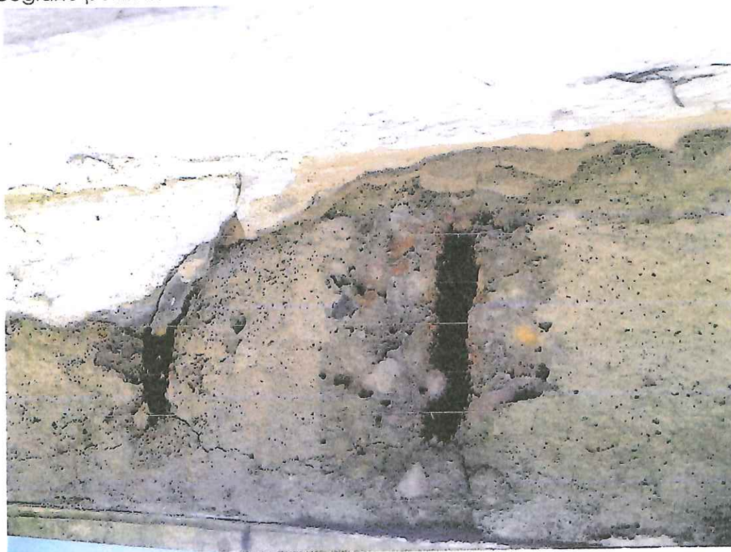
Fragment podniebia balkonu na elewacji północnej – widoczna korodująca konstrukcja, odsłonięta w miejscu ubytków tynku. Tynki wtórne, wapienne i cementowe
