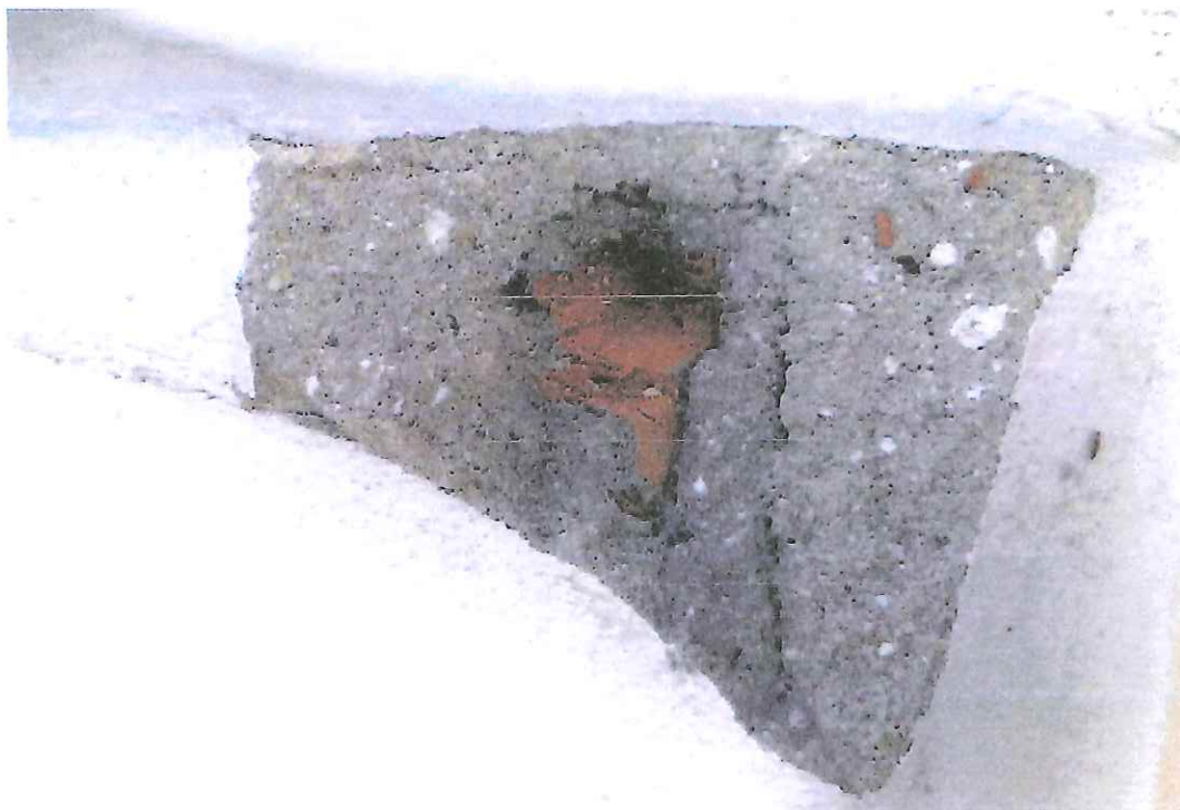
Wtórna warstwa tynkarska z zaprawy cementowej, nałożona bezpośrednio na ceglane podłoże
